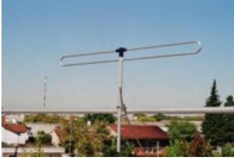
Dipolo en proceso de medición
